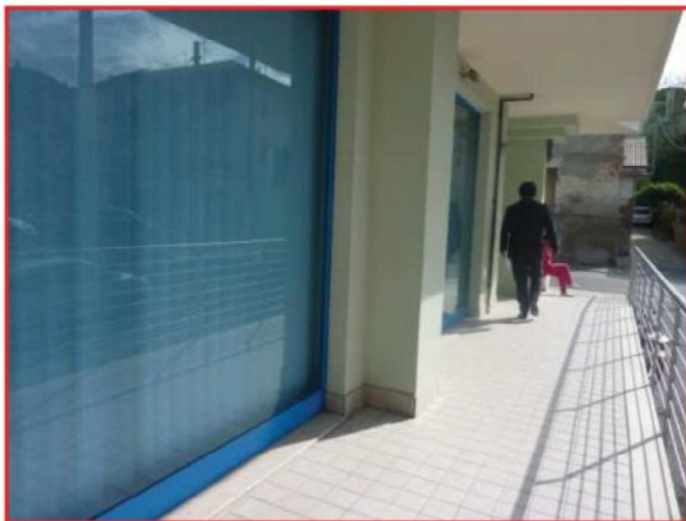
FOTO 04 - Vista esterna su lato passerella condominiale
